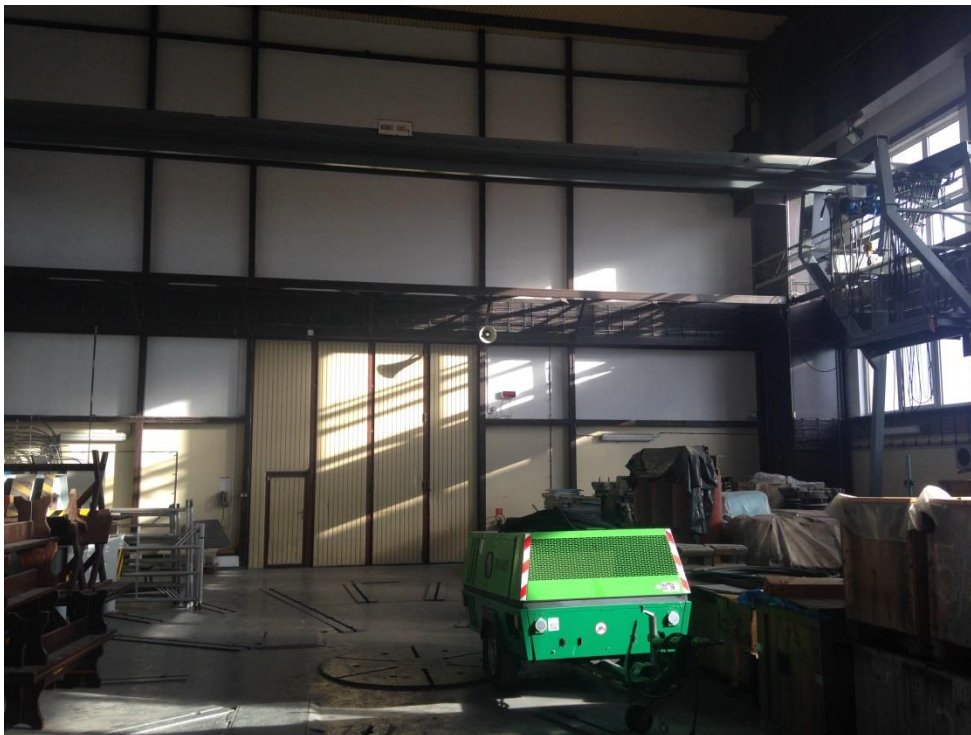
Obr. č.2 Kozový žeriav 1t v montážnej hale
